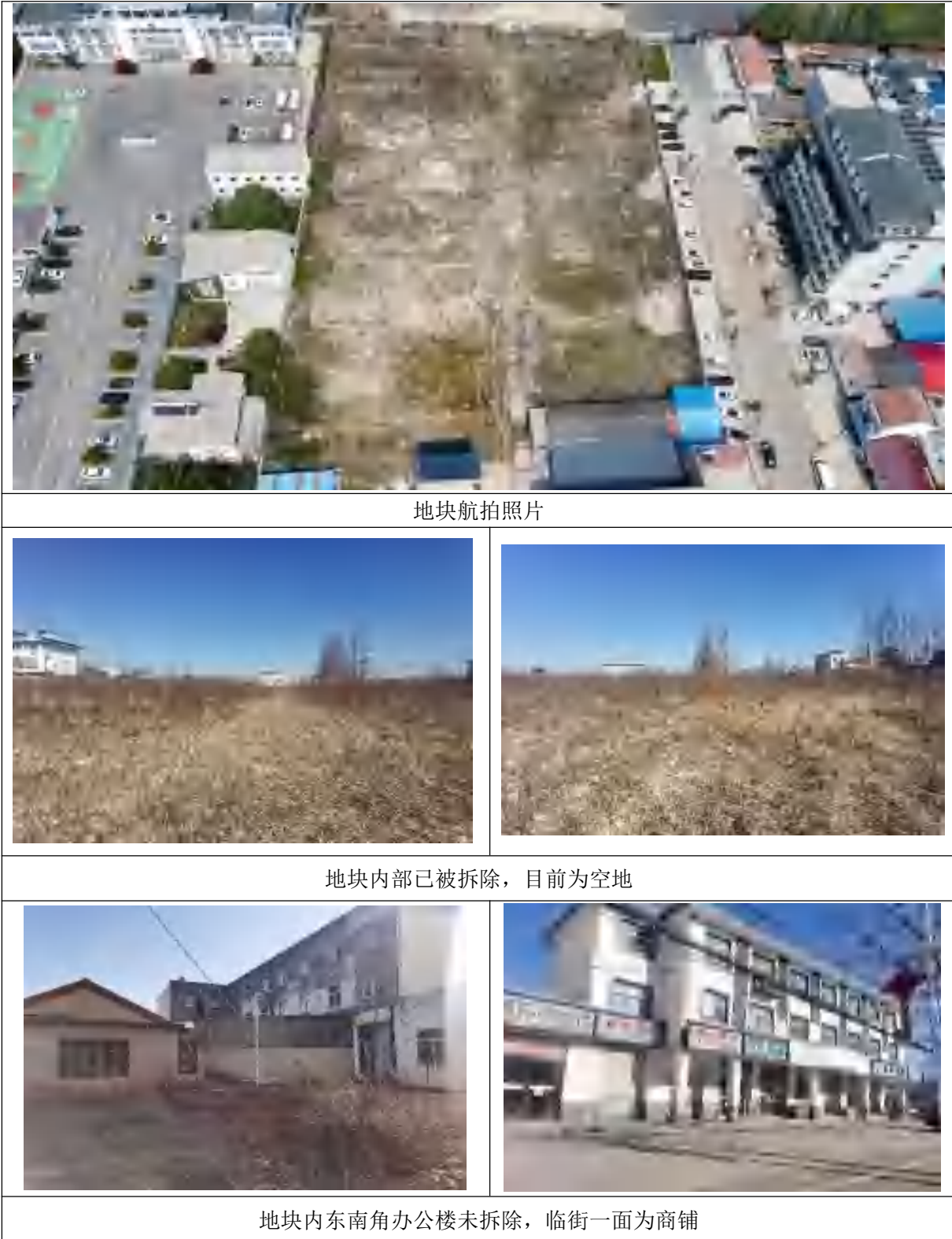
图3.3.2-1 地块内现状照片
