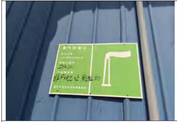
废气排口标 牌
