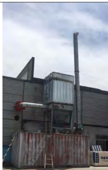
裁边、砂光废气处理设施及排口
