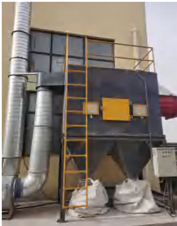
上料混合废气处理设施及排气筒
