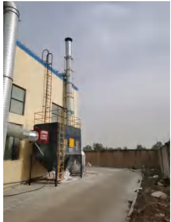
上料混合废气处理设施及排气筒
