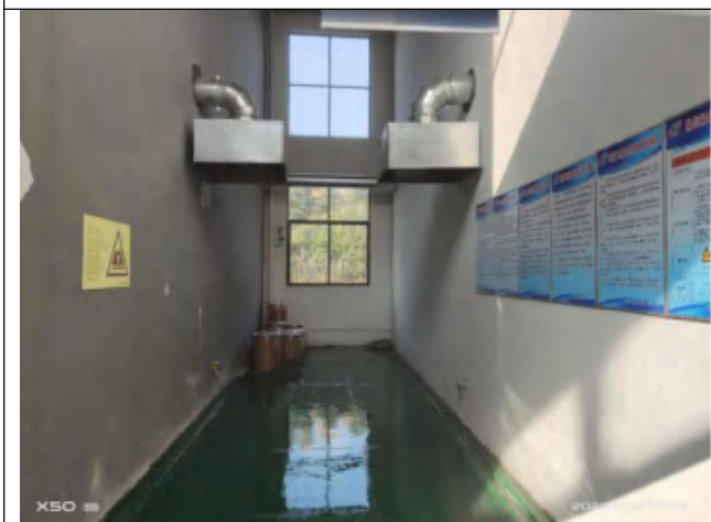
涂布车间逸散废气处理设施
