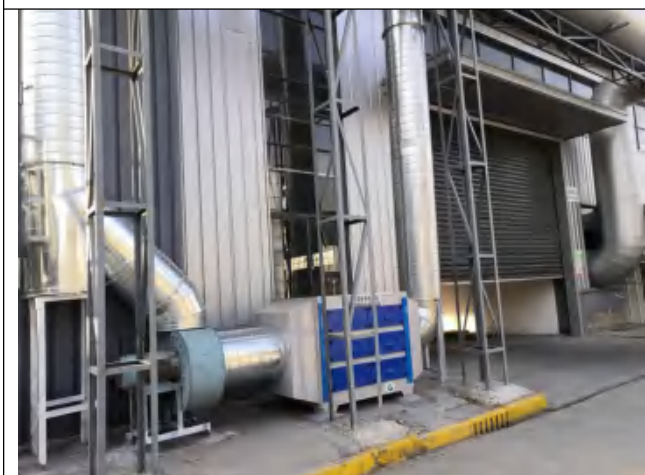
涂布车间逸散废气处理设施
